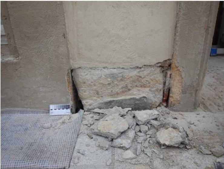
Nach Abnahme der Überzüge wurde das schadhafte Material bis auf den stabilen Bereich zurückgearbeitet.
