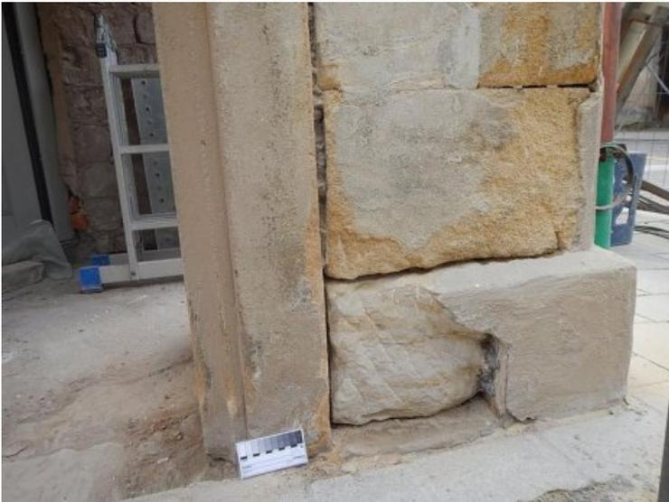
Als Vorbereitung für Steineränzungen wurden gelockerte Bereiche entfernt und zur Verkrallung des Mörtels mit Spitzhieben versehen.
