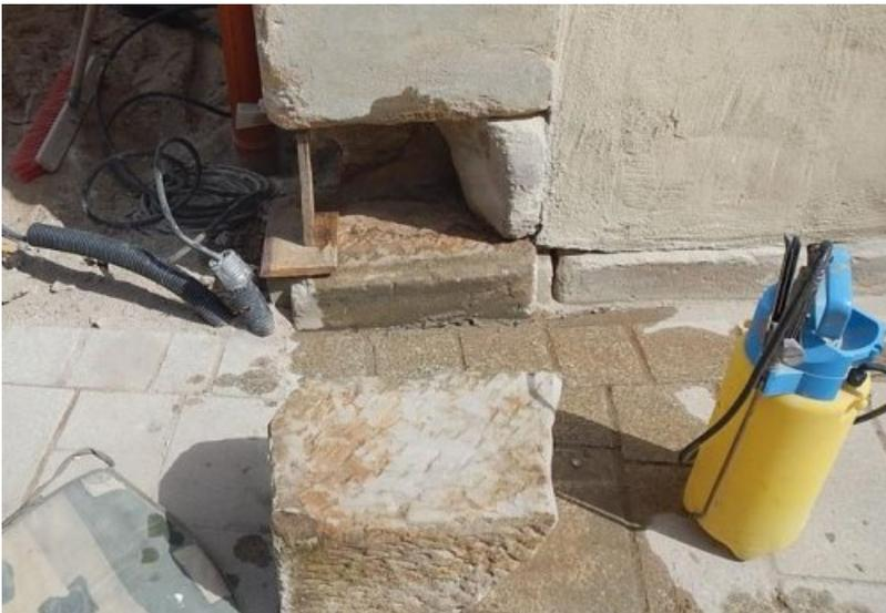
Die gelockerten Steine der Ecklisenen wurden unter Abstützung der oberen Bauteile entfernt und für die Rückvernadelung vorbereitet.
