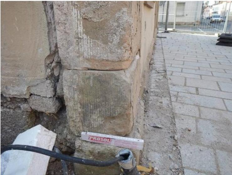
An den Quadersteinen der Ecklisenen treten Fehlstellen auf, die Formverluste insbesondere an den Werksteinkanten verursachen.
