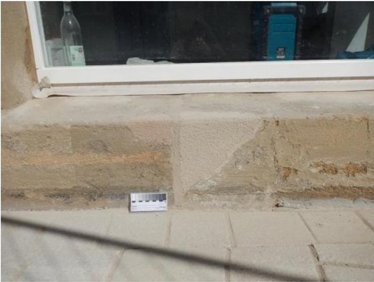
Die Steinerganzungen wurden in Form, Farbe und Struktur an das Originalmaterial angepasst.
