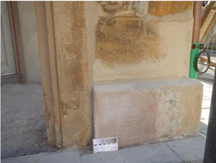
Durch Steinerfüllmassen ist die Formenkontinuität des Werksteins wiederhergestellt.
