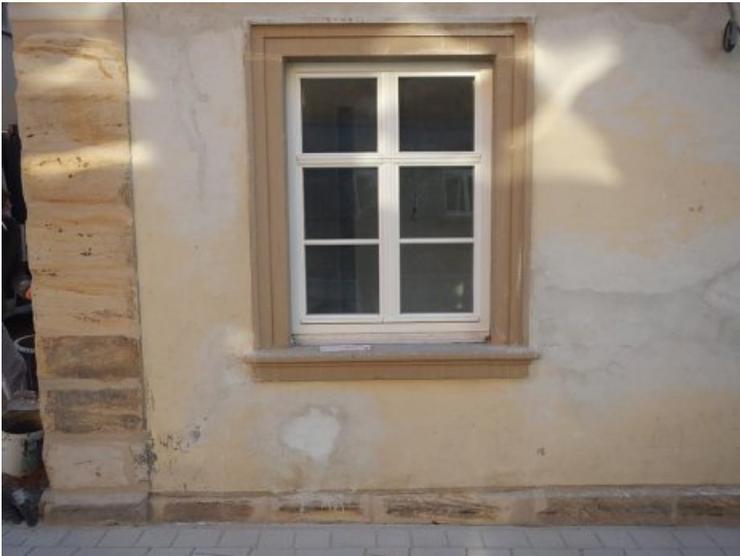
Der Sockel ist in Form und Funktion saniert, die losen Farbschollen der Wandflächen wurden entfernt.
