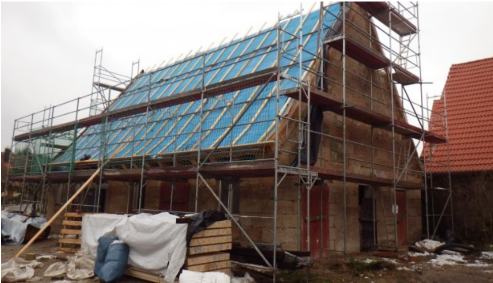
Das Gebäude während des Umbaus.
