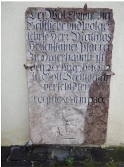
Das Epitaph aus rotem Knollenkalk ist stark geschädigt und massiv durch Feuchtigkeit belastet.
