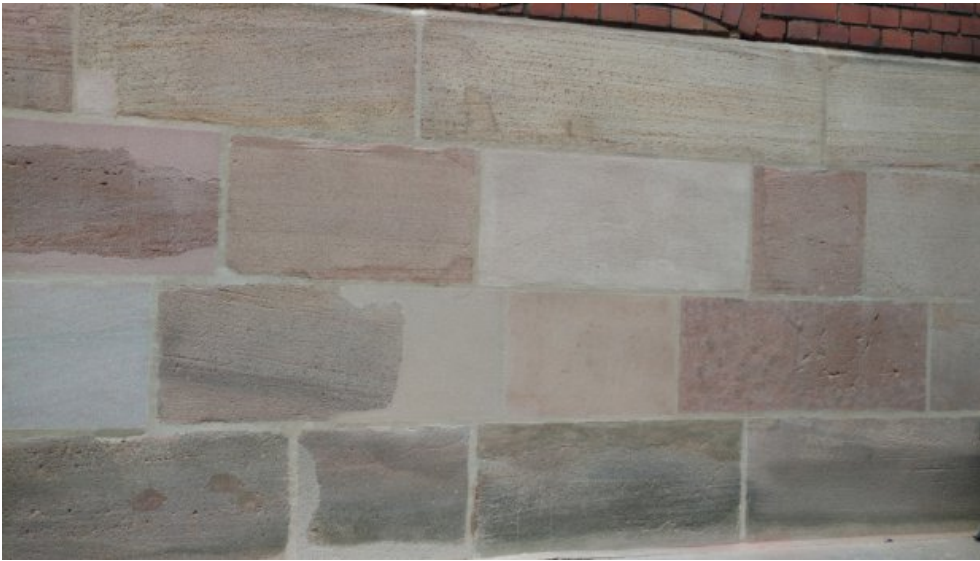
Die Durchgangsseite nach der Restaurierung.
