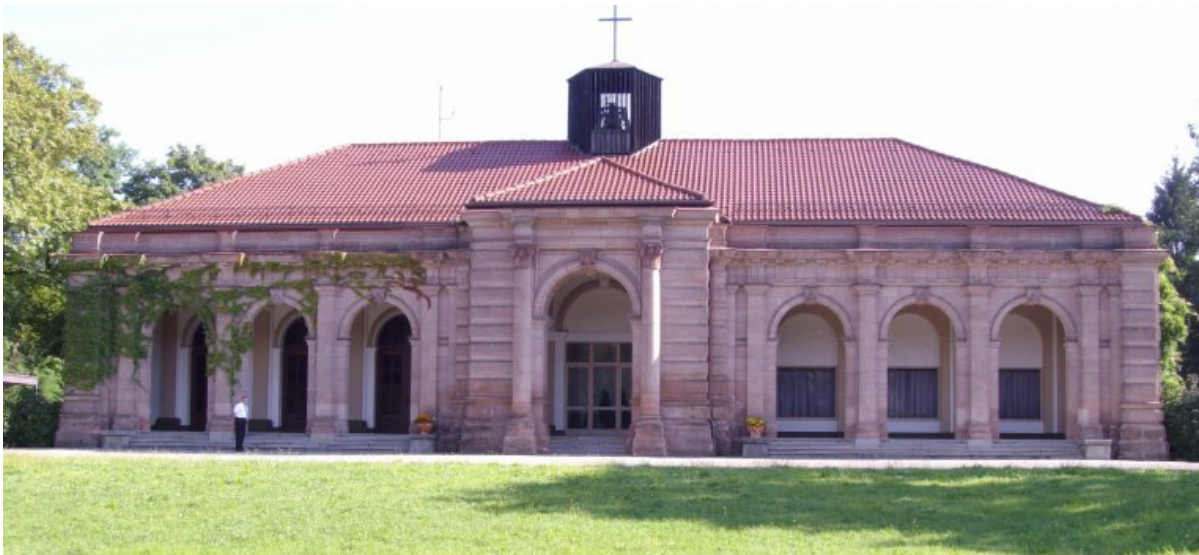
Vorzustand der Hauptfassade der Aussegnungshalle, 2008
