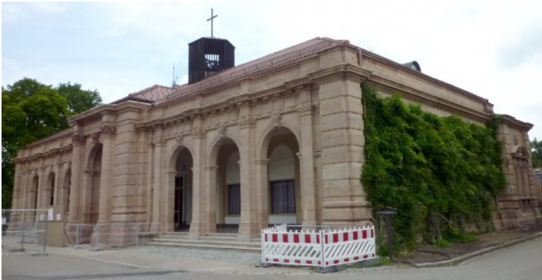
Schräge Ansicht von der Halle nach Fertigstellung Natursteinrestaurierung 2010
