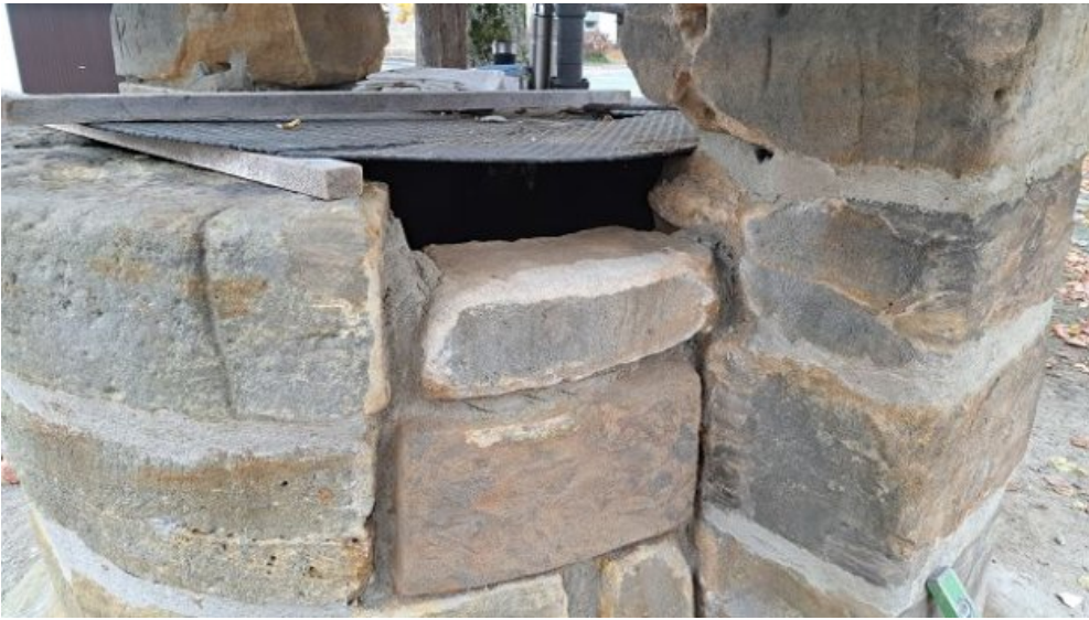
Zwischenzustand nach dem Versetzen einer Vierung (steinernes Ersatzstück) am Brunnenrand.
