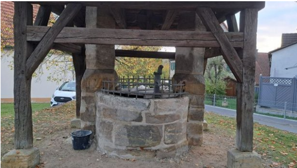
Aufnahme des Zwischenzustandes während dem Neuverfugen.
