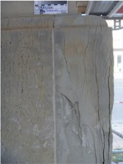
Nach der Beschichtungsreduzierung wurde ersichtlich, dass große Bereiche zahlreiche Risse, entfestigte Bereiche und Fehlstellen aufweisen.
