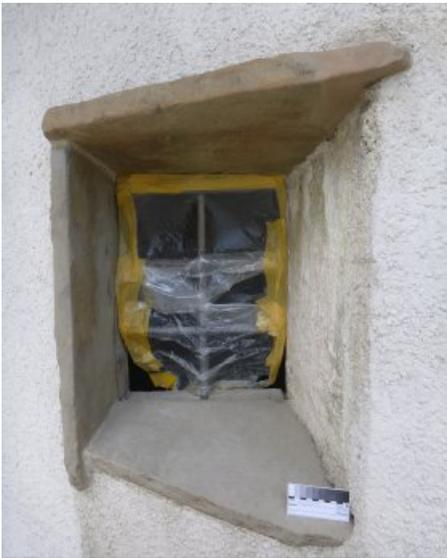
Fehlstellen an Solbank, Sturz und Laibung wurden mit Steinersatzmasse ergänzt und Risse und Schalen geschlossen.
