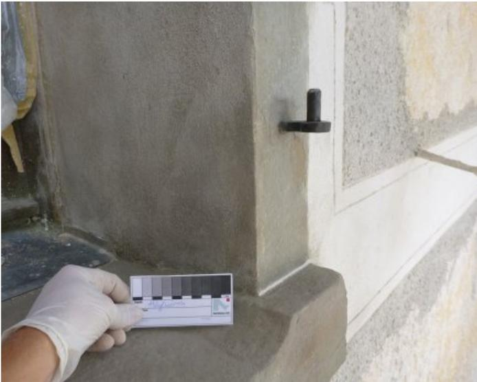
Nach Rückarbeiten der alten Fenstekloben, bauseitiger Montage der neuen Kloben und Schließen der Einbindestelle mit Steinersatzmasse.
