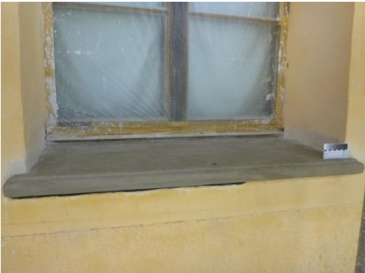
Fensterbank nach Reinigung, Sicherung von Rissen und Schalen, Ergänzung von Fehlstellen und Einschneiden einer Wassernase.
