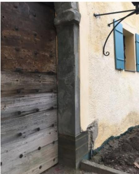
Die Fehlstelle wurde durch ein Neuteil geschlossen. In das Neuteil wurden Scheinfugen eingearbeitet.
