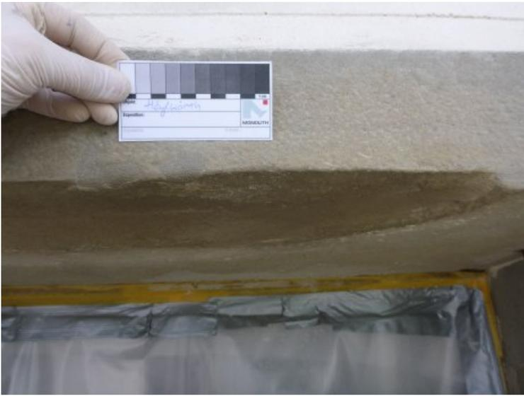
Nach Sicherung der großformatigen Schalen im Fenstersturz.
