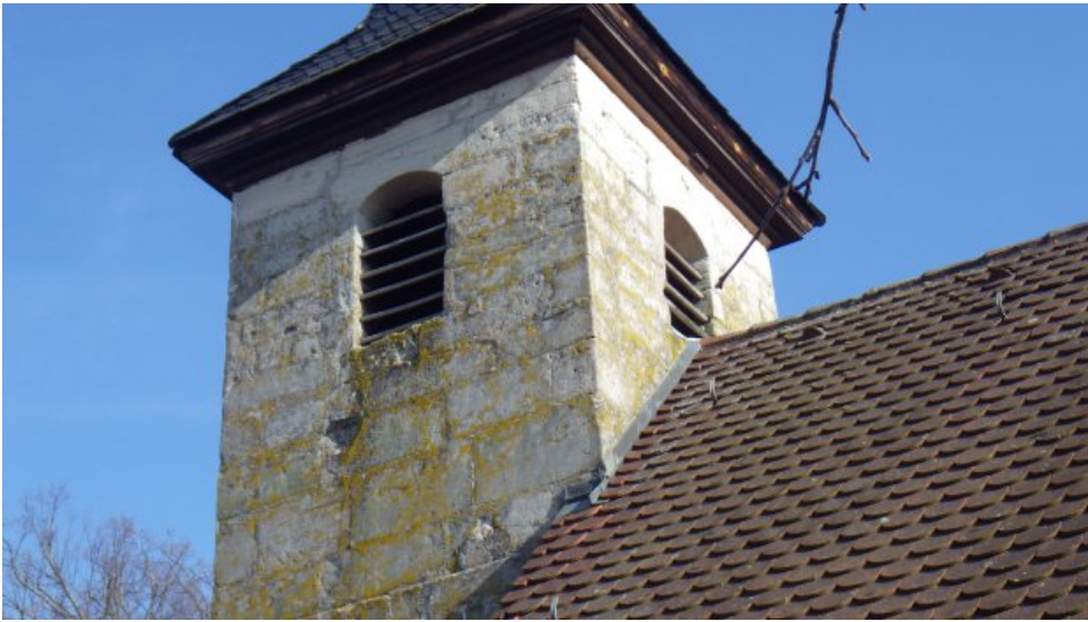
Detail des Turms vor der Restaurierung.
