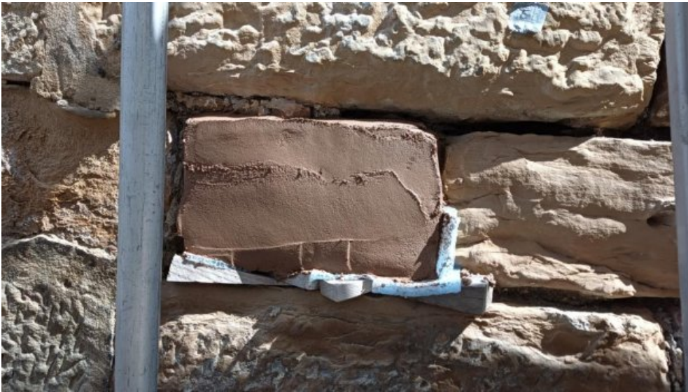
Steinergänzungen wurden mit Salzspeichermörtel ausgeführt.
