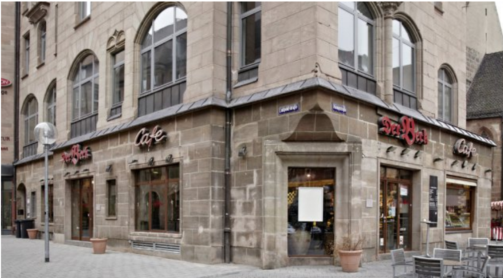
Das Mauerwerk im Erdgeschoss vor der Freilegung.
