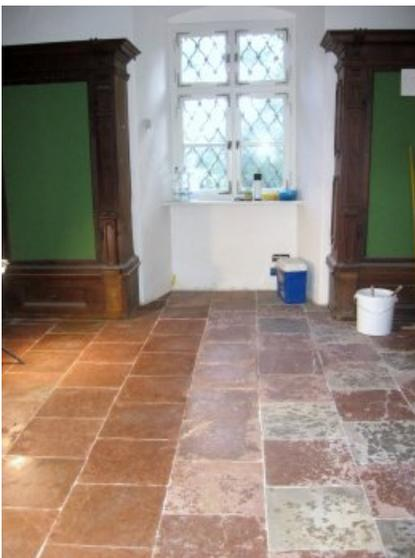
Ausschnitt Fußboden links fertiggestellt und rechts nach Salzminimierung und Trockenreinigung
