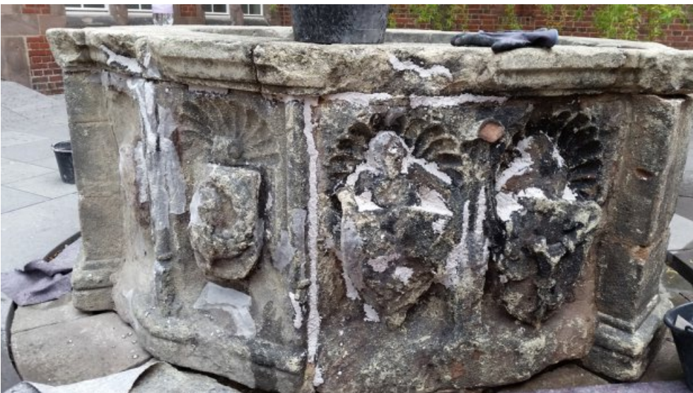
Fragile Bereiche wurden vor dem Auftrag der Salzreduzierungskompresse mit Japanpapier gesichert.
