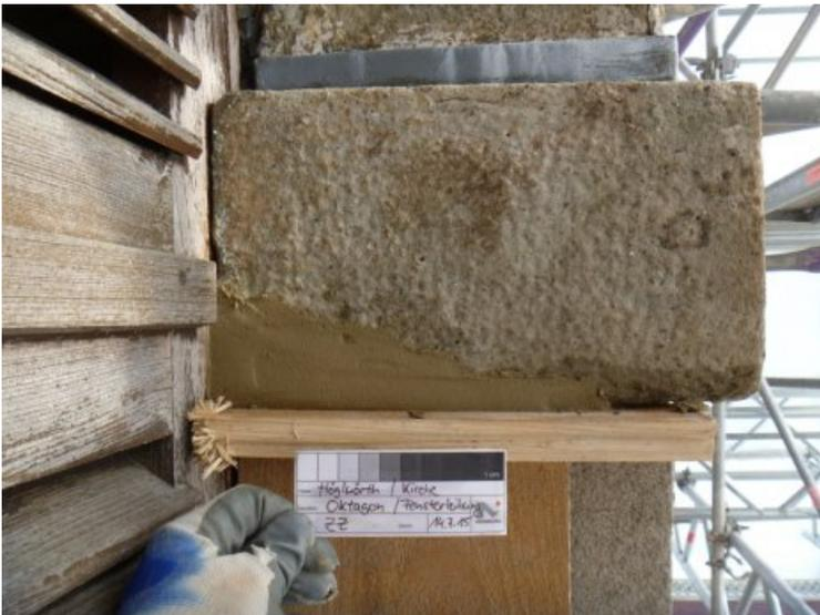
Beim Ergänzen wurde Steinersatzmasse über Niveau angetragen und nach Erhärten des Mörtels an den Bestand angepasst.
