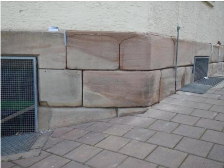
Ausgearbeitete Fugen und ergänzte Werksteinkanten
