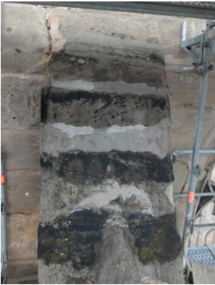
Insbesondere am oberen Pfeilerbereich waren im Vorfeld Schäden, wie defekte Altmörtel und entfestigte Sandsteinbereiche zu verzeichnen.
