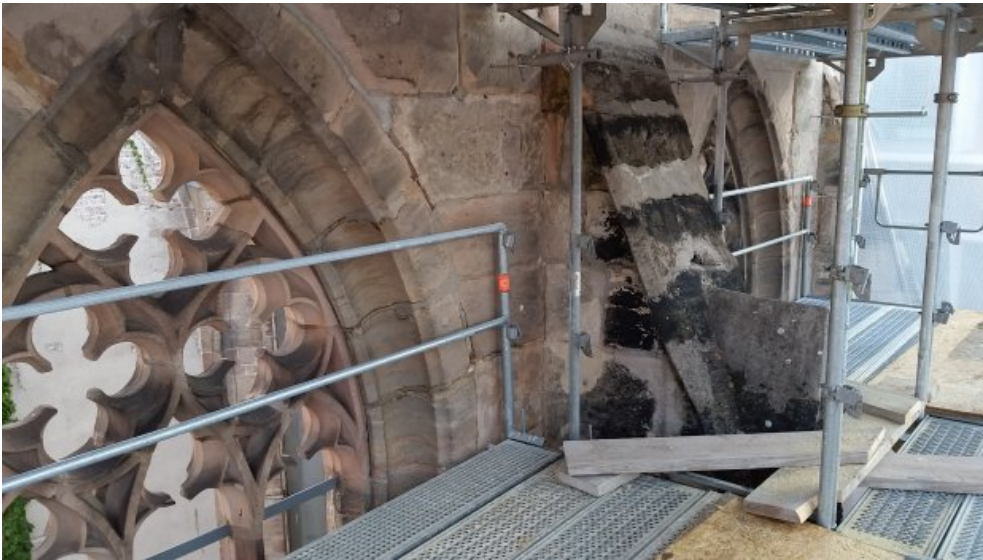
Der obere Bereich der Musterfläche im Vorfeld der Maßnahme.
