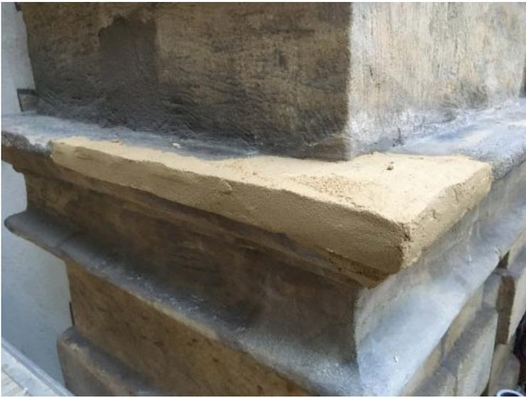
Detail Ergänzungen: es erfolgte das Antragen des vorkonfektionierten Steinersatzmörtels, der in Körnung, Struktur und Farbigkeit dem Bestand angepasst ist, über Oberflächenniveau
