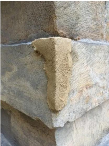
Detail Ergänzungen: es erfolgte das Antragen des vorkonfektionierten Steinersatzmörtels, der in Körnung, Struktur und Farbigkeit dem Bestand angepasst ist, über Oberflächenniveau.
