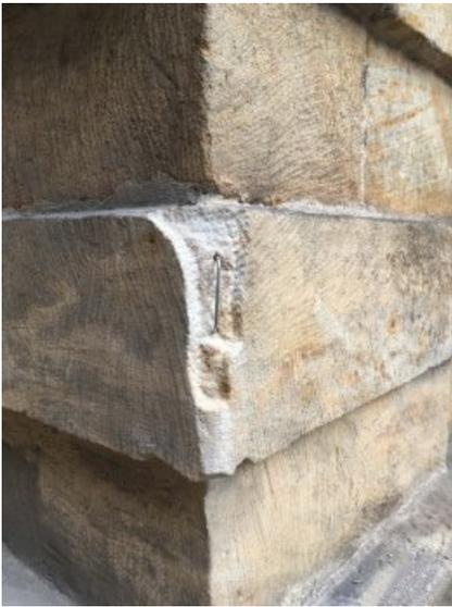
Detail Ergänzungen: Nach Rückarbeiten geschädigter Bereiche, Einbeizen der Fehlstellenflanken zur besserung Haftung des Mörtels, Einkleben von Edelstahl-Armierungen gegen die Fallrichtung.
