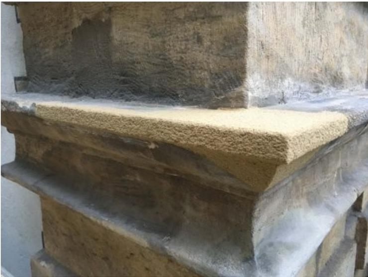
Detail Ergänzung: Entfernen der Sinterschicht nach Erstarren der Masse sowie Wiederherstellen der Oberflächenbearbeitung des Natursteins.
