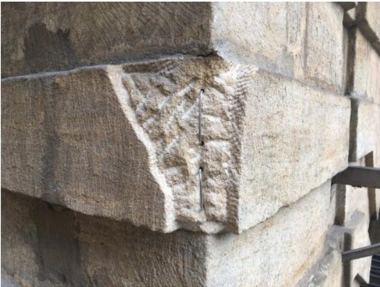
Detail Ergänzungen: Nach Rückarbeiten geschädigter Bereiche, Einbeizen der Fehlstellenflanken zur besserung Haftung des Mörtels, Einkleben von Edelstahl-Armierungen gegen die Fallrichtung.
