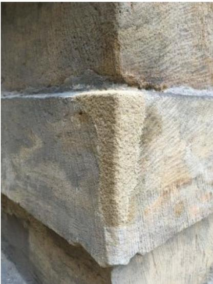
Detail Ergänzung: Entfernen der Sinterschicht nach Erstarren der Masse sowie Wiederherstellen der Oberflächenbearbeitung des Natursteins.
