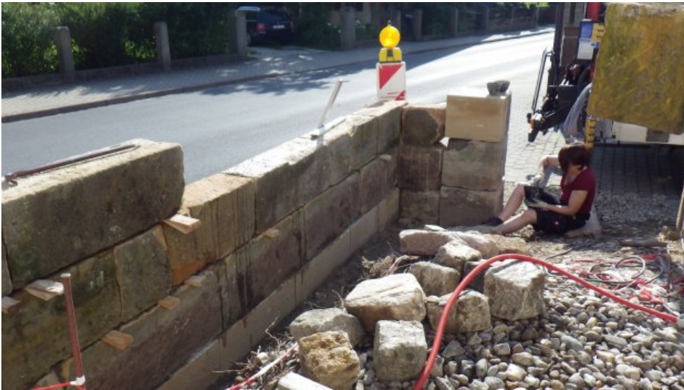
Während des Wiederaufbaus.
