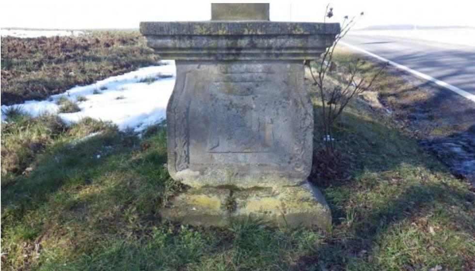
Sockel mit Darstellung 'Schweißstuch der Veronika', vor der Reinigung. Das Relief ist bereits stark zurückgewittert, Fehlstellen erkennbar.
