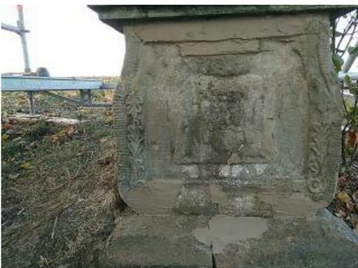
Schalen wurden gesichert und Fehlstellen mit in Körnung, Struktur und Farbigkeit passendem Mörtel über Niveau geschlossen.
