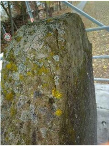
Detail des Kreuzigungsreliefs, Aufsicht, Deutlich sind die Flechten und Moose sowie ein oberflächenparallel verlaufender Riss erkennbar.
