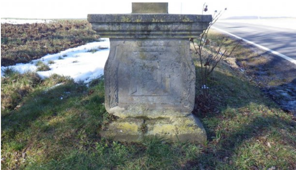
Sockel mit Schweißtuchdarstellung, vor der Reinigung. Das Relief ist bereits stark zurückgewittert, Fehlstellen erkennbar.
