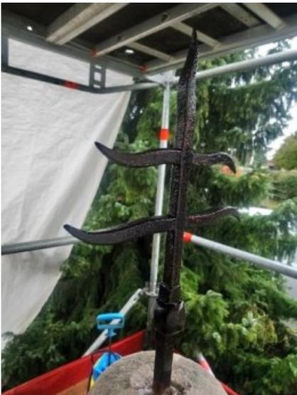
Zwischenzustand: Das korrodierte Metallkreuz wurde handentrostet und mit einer Rostversiegelung grundiert.
