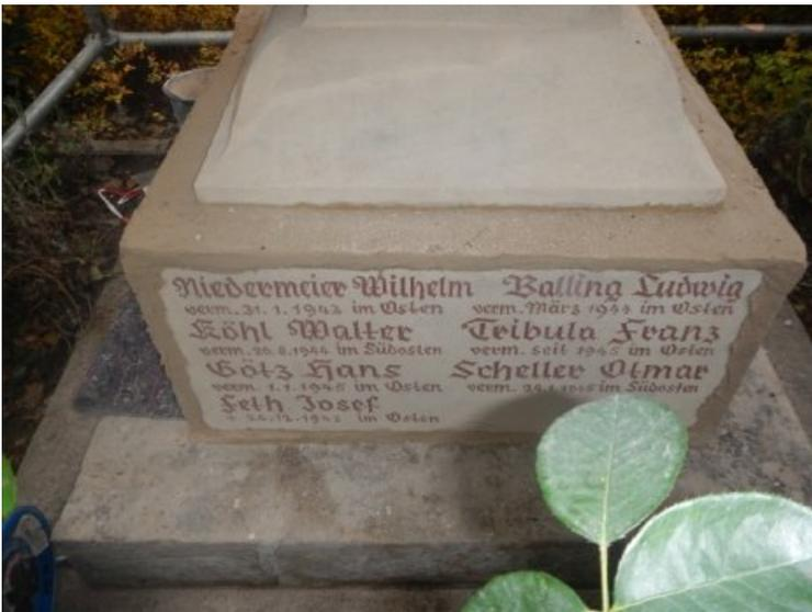
Zwischenzustand: Die Schriftplatten wurden mit Halteankern kippsicher neu versetzt. Die Fugen wurden verschlossen und die Anschlussbereiche an den Sockel ergänzt.
