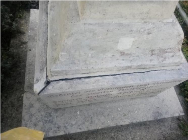
Zwischenzustand: Die Fugen um die Schriftplatten im Sockelbereich sind abgerissen und ausgewittert.
