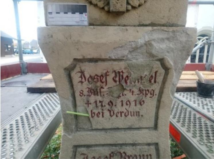
Zwischenzustand: Vorbereitung zum Hinterfüllen der dünnen Schalen an der Südseite.
