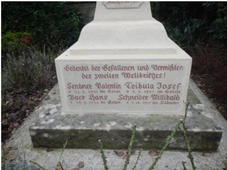
Endzustand: Nach Trocknung fügt sich die Ergänzungsmasse harmonisch in den Bestand, die nachgefasste Schrift ist gut lesbar.
