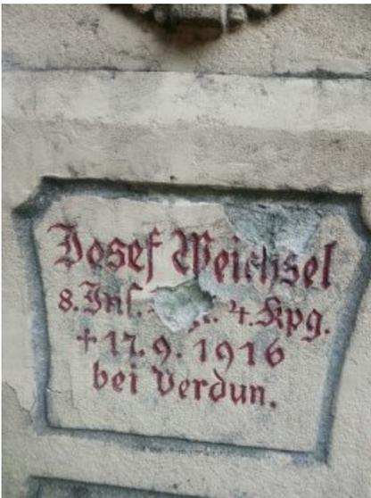
Vorzustand: Oberflächenparallele Ablösung in Form dünner Schalen tertien an mehreren Stellen auf.
