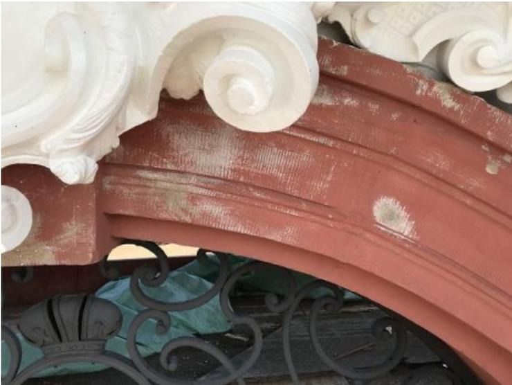
Detailansicht des Segmentbogens am sog. Memmelsdorfer Tor im Vorzustand (teilweiser Fassungsverlust, Beschädigung der Oberfläche).
