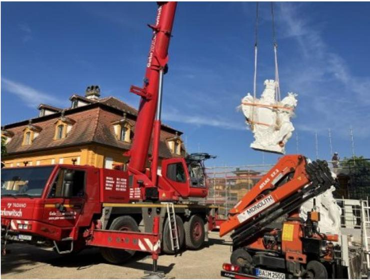
Wiederversetzen der restaurierten Wappenlöwen (Bauzier) an der westlichen Toranlage mittels Hebekran.
