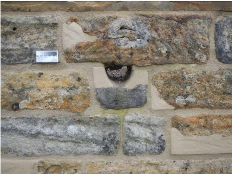
Detailaufnahme eines anderen Seeufermauer-Abschnittes nach dessen Restaurierung und Wiederherstellung des Fugenbildes. Die Öffnung dient u.a. als Wasserablauf, um Staunässe zu vermeiden.
