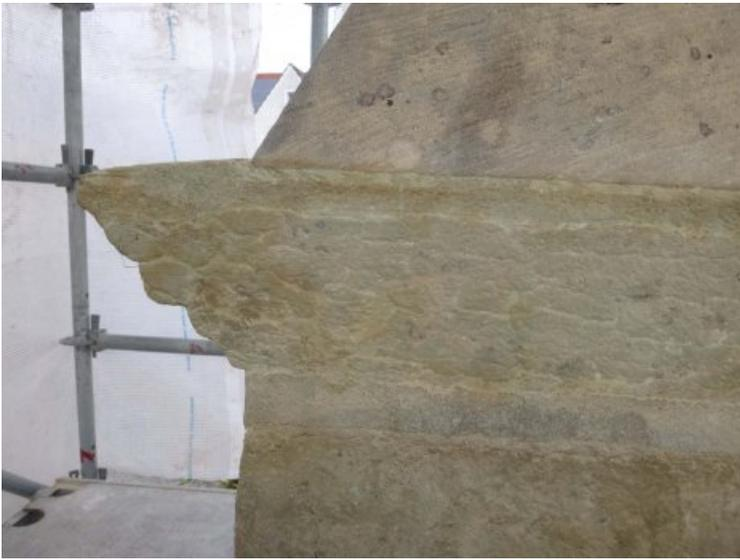
Die Risse und Flankenabrisse wurden mit einem mineralisch gebundenen Mörtel, der in Farbe und Struktur dem Stein angepasst wurde, geschlämmt.
