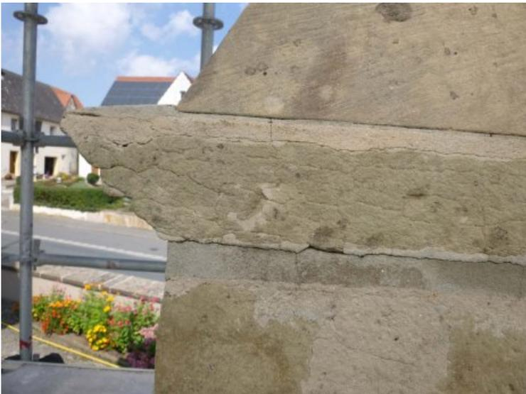
Nach Reinigung von Schmutz und biogenem Bewuchs erkennbar gewordene Risse sowie Abrisse der Fugenflanken.
