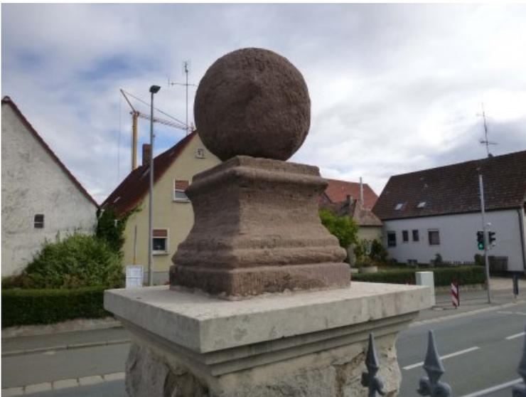
Pfeileraufsatz nach Reinigung, Sicherung von Rissen und Schalen sowie der Sicherung von Fugen bzw. Fugenflanken.
