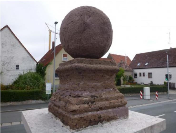
Pfeileraufsatz vor der Maßnahme, deutlich erkennbarer biogener Bewuchs, Schmutz, Risse und schalende Oberfläche.
