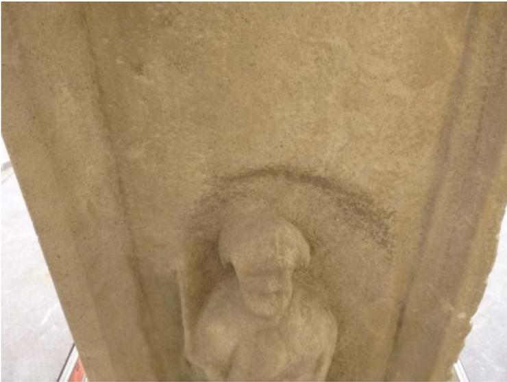
Der Riss wurde mit mineralischer Steinersatzmasse verschlossen.
