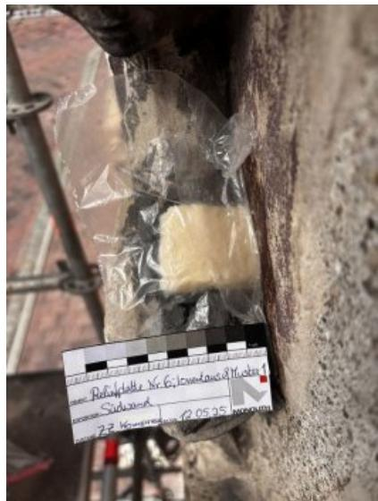
An kleineren Bereichen wurden Musterflächen für die Reduzierung der Sulfatbelastung mittels Ionentauscherharzkompressen angelegt.
