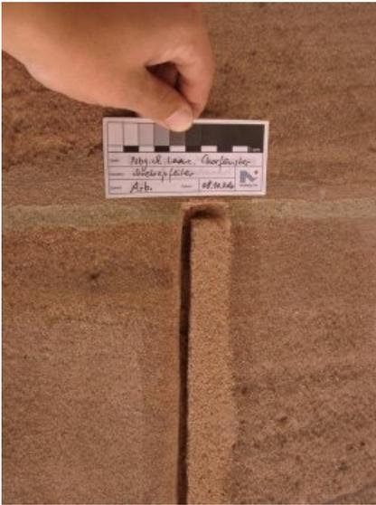
Ergänzung der Steinflanken mit Kieselzementmörtel
