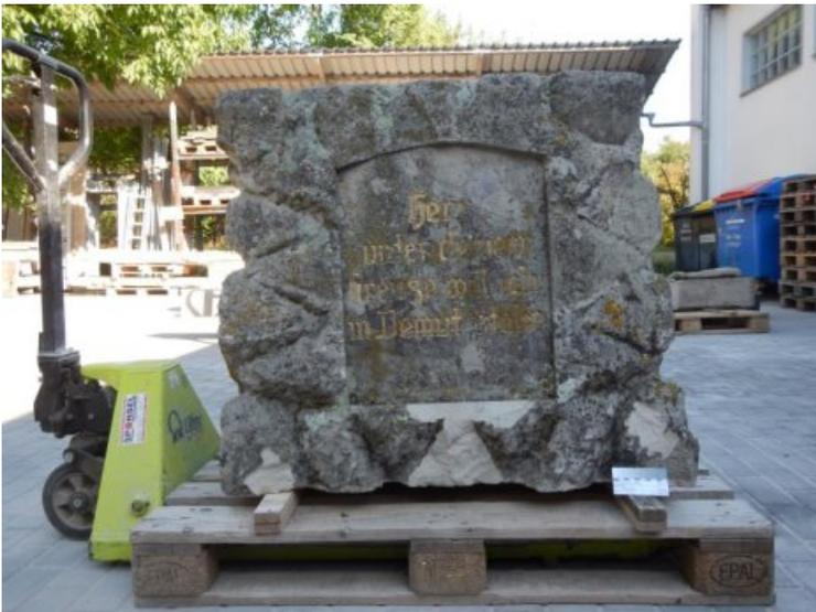
Verschmutzter und ausgeplatzter Sockel
