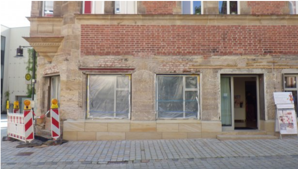
Das Sockelmauerwerk wurde mit Sandsteinplatten verblendet.
