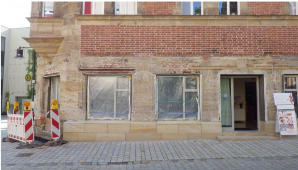
Das Sockelmauerwerk wurde mit Sandsteinplatten verblendet.
