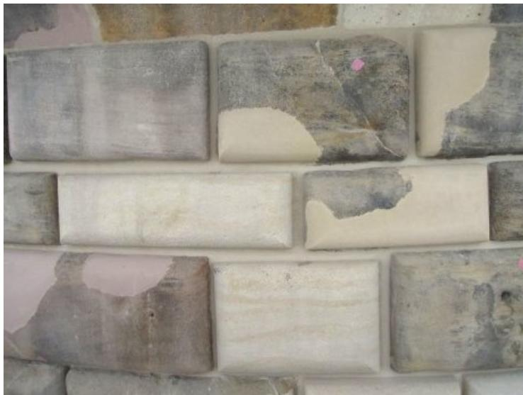
In den Bestand integrierte Neuteile, wiederhergestelltes Fugenbild und ergänzte Fehlstellen - die Retusche dieser stand zum Zeitpunkt der Fotoaufnahme noch aus.
