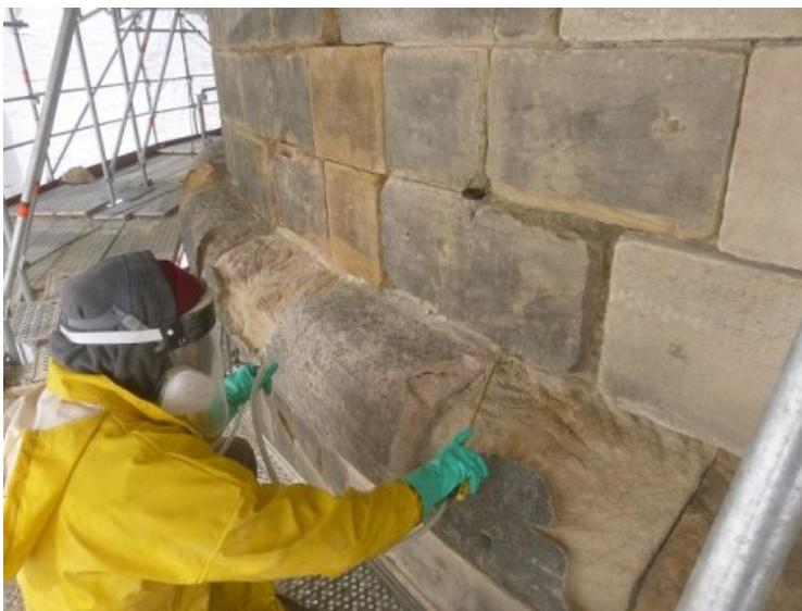
Absandende Partien wurden mittels Airless-Pumpensystem und KSE gefestigt.
