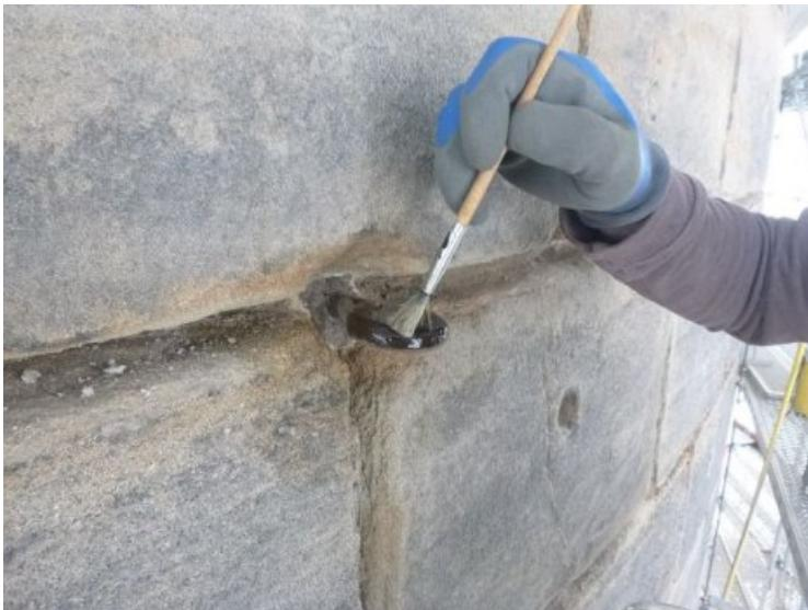
Metallteile, die am Objekt verblieben, sind mittels Rostschutz konserviert worden.
