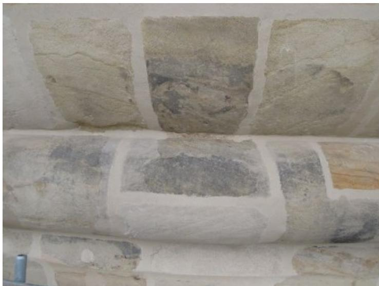
Vollständig in den historischen Bestand integriertes Neuteil entlag des Wulstgesimses sowie wiederhergestelltes Fugenbild.
