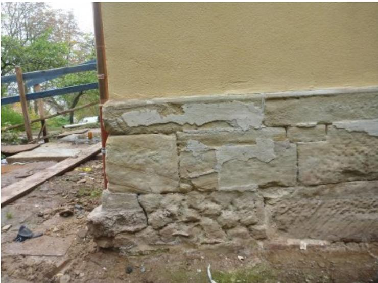
Nach dem Entfernen von Altergänzungen und defekten Fugen.
