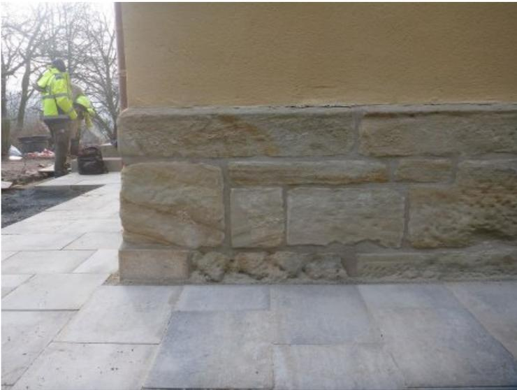
Nachzustand: Eingesetzte Vierungen und Neuteile, Ergänzungen, Fugenaustausch.
