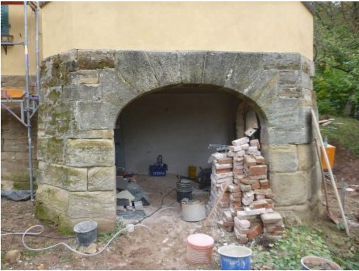
Nach der Entfernung von defekten Fugen, Altergänzungen und entfestigten Bereichen.
