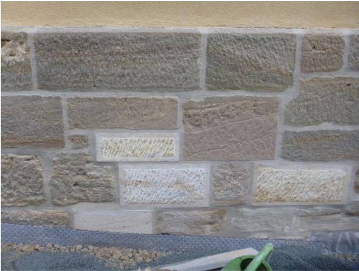
Nachzustand: Eingesetzte Vierungen und Neuteile, Ergänzungen sowie abgeschlossener Neuverfugung.
