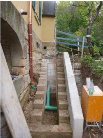
Die alten Stufen der 10-stufigen Treppe an der Ostseite wurden ausgebaut.
