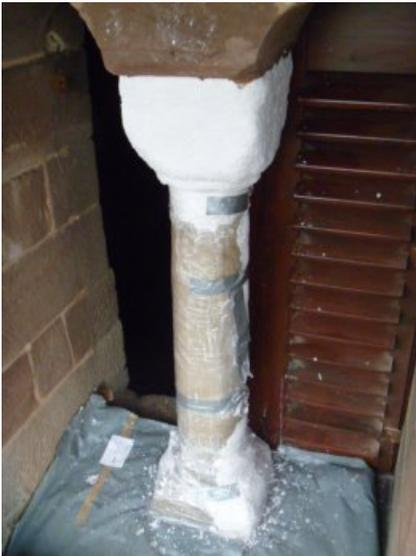
Während der Sulfatreduzierung an den Stützen der Zwillingsfenster
