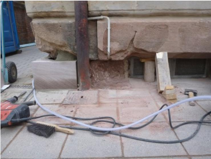
Zur Wiederherstellung Wasserablaufes und der Form wurden Bereich des Sockels durch Steinersatzmasse und Neuteile wieder ergänzt.
