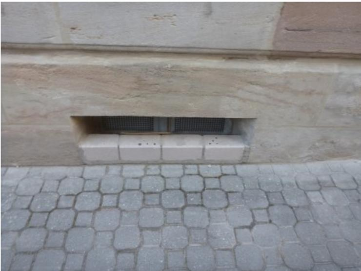
Ergänzungen wurden nach Entfernung der Sinterschicht und Wiederherstellung der Oberflächenstruktur durch Retusche farblich angepasst.
