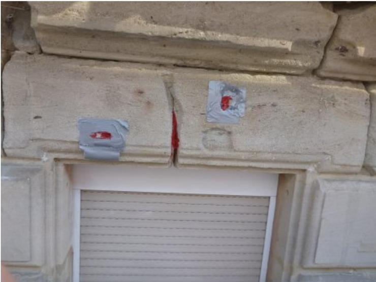
Nach Einbringen von V4A - Gewindestäben, Verfüllen und Einkleben der Gewindestäbe mit Epoxidharz, folgt das Schließen der Bohrlöcher und des Risses.
