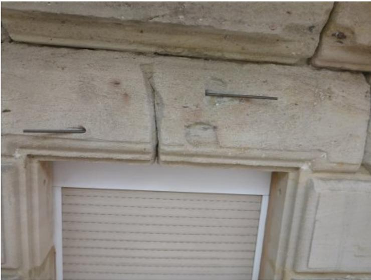
Zur Sicherung und zur statischen Ertüchtigung lasttragender und gebrochener Steinteile wurden Nadeln gesetzt.
