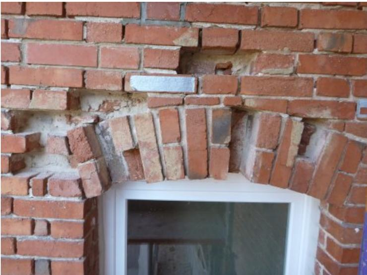
Stark geschädigte Bereiche im Ziegelmauerwerk und einzelne, stark reduzierte Ziegel wurden ausgebaut und durch neue Vollziegel im gleichen Format ersetzt.
