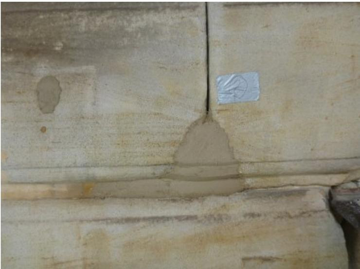
Antragen des vorkonfektionierten Steinersatzmörtels, der in Körnung, Struktur und Farbigkeit dem Bestand angepasst ist.
