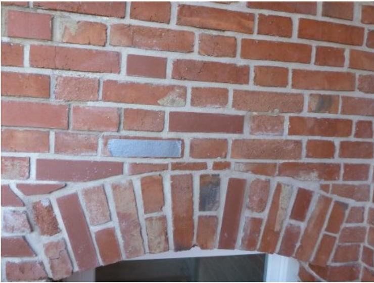
Intakte Ziegel innerhalb stark geschädigter Mauerwerksbereiche wurden ebenfalls ausgebaut aber anschließend wieder versetzt.
