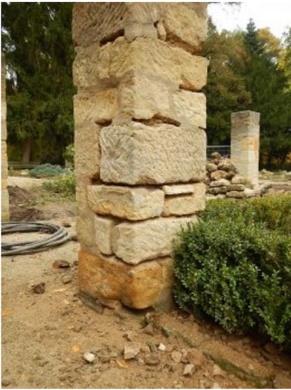
Nach Reinigung und Ausbau defekter Fugenmörtel am Pfeiler.
