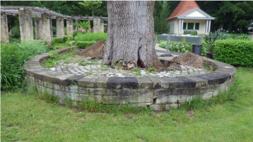
Die Einfassungsmauer wies durch aufgrund des Wachstums des Baumes entstandenen Druck Schäden auf.
