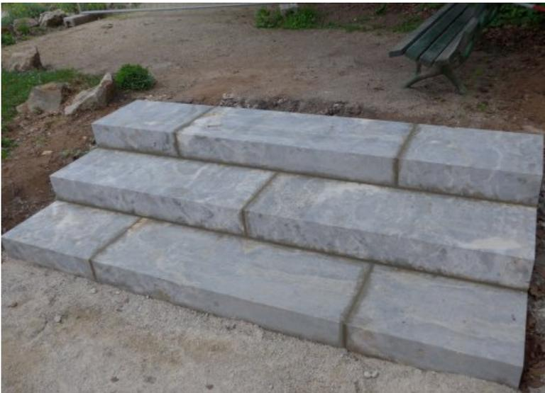
Reduzierte und mehrfach gebrochenen Stufen waren durch Neuteile aus Dolomit ersetzt worden.
