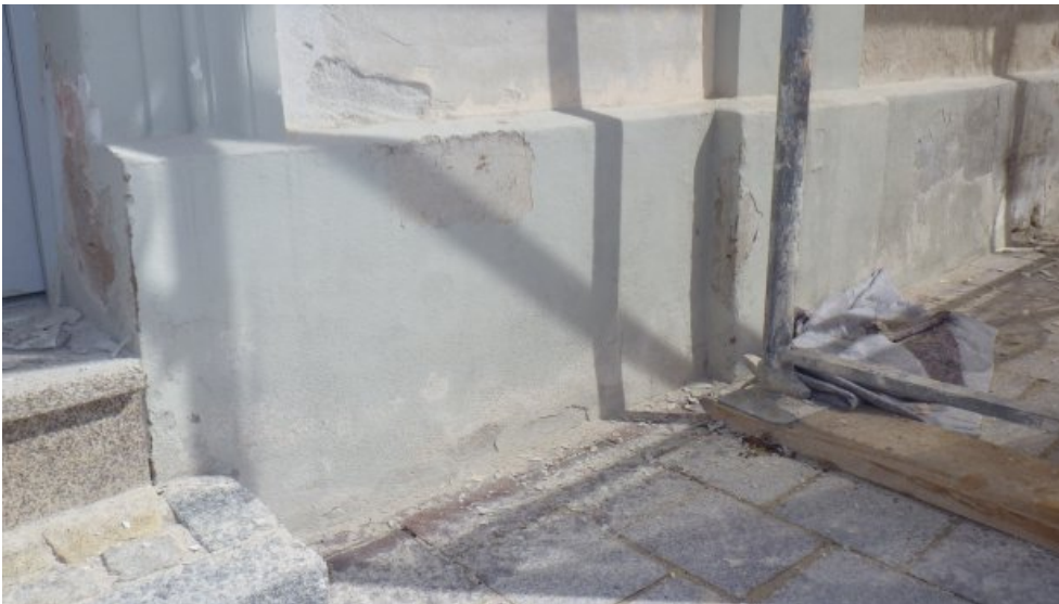
Das Sockelmauerwerk vor der Restaurierung mit Beschichtung.
