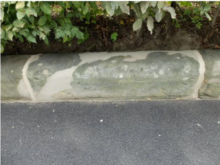
Die abgelöste Schale wurde gereinigt und mit dem kerngestein verklebt, die Fehlstellen mit Steinersatzmörtel oberflächenbündig geschlossen.
