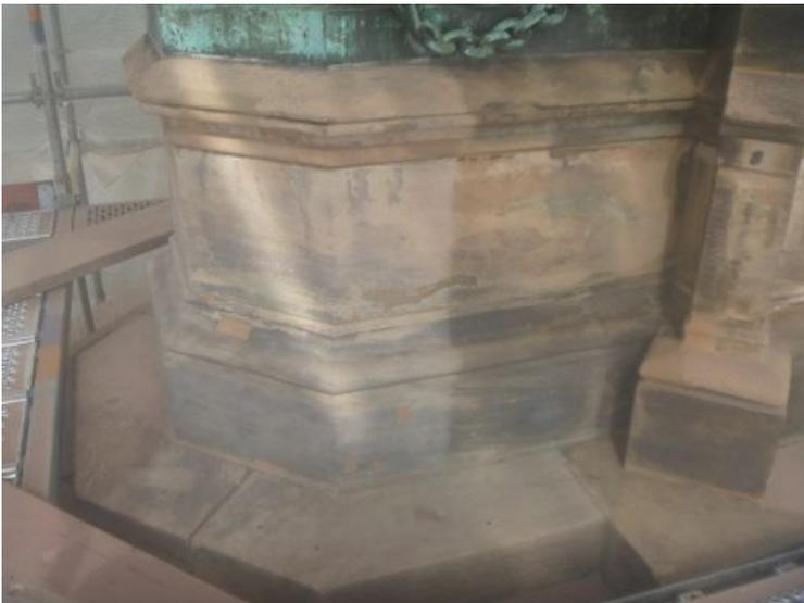
Optische Verbesserung und Vereinheitlichung durch die Reinigung und Ausdünnung von Krusten an der Oberfläche des Sandsteins.
