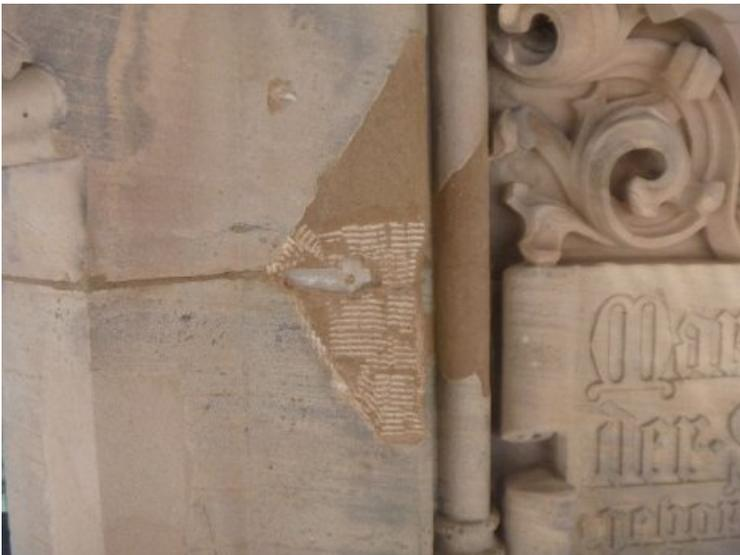
Ausarbeiten der fehlerhaften Altergänzung und Vorbereitung des Untergrundes für das Auftragen des Steinerfüllmörtels.
