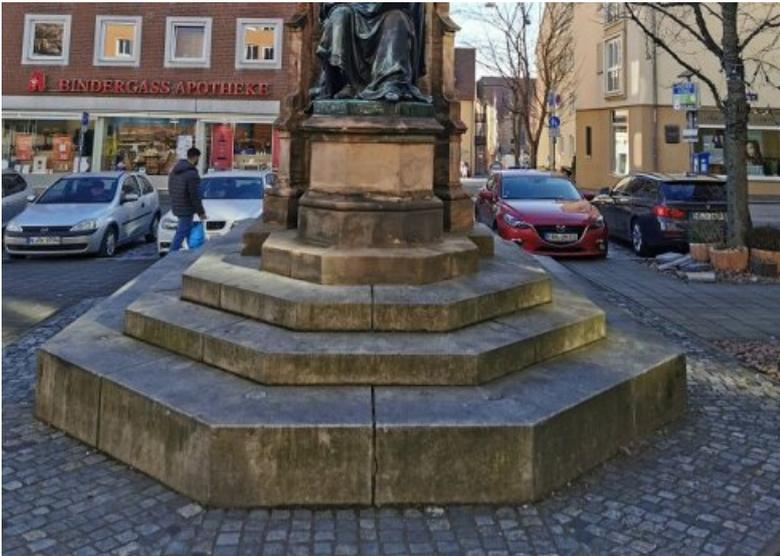
Der Granitunterbau mit schadhaftem Fugenbild und loser Stufe.
