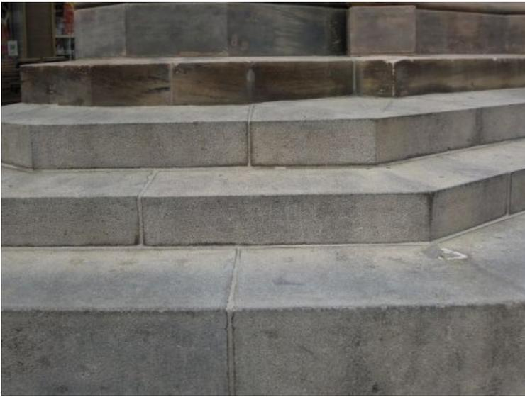
Detailaufnahme des Granitunterbaus nach dessen Restaurierung mit wiederhergestelltem Fugenbild.
