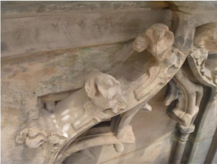
Ausbessern einer Fehlstelle sowie Ergänzung der Krabbe mit farblich und technisch angepasstem Mörtel.
