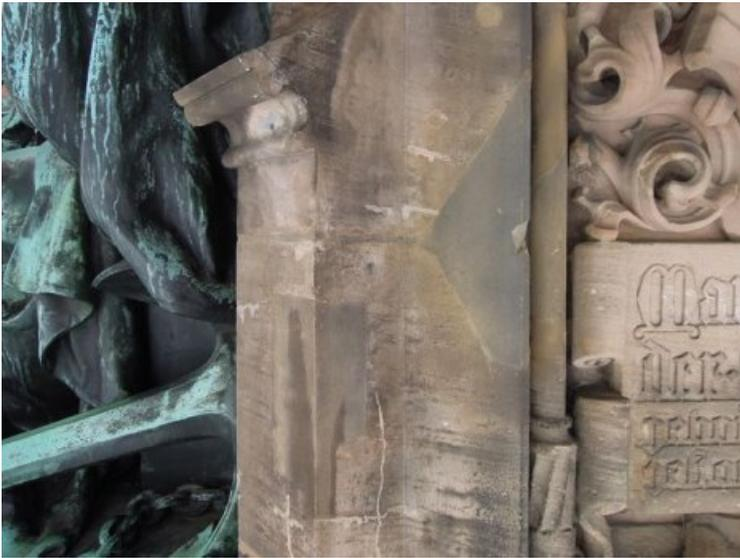
Fehlerhafte Ausführung einer Altergänzung: der Fugenschnitt wurde hier nicht berücksichtigt.
