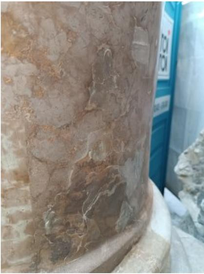
Das defekte Altmaterial wurde ausgearbeitet und mit einer technisch und visuell an den Originalstein angepassten Steinersatzmasse ergänzt.
