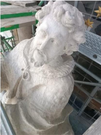
Nachdem die Schäden konsolidiert waren, wurde als Witterungsschutz und zur visuellen Vereinheitlichung eine diffusionsoffene Lasur aufgetragen.
