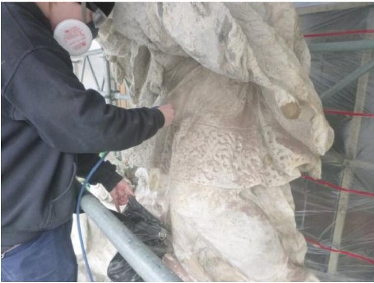
Entfernen grau-schwarzer Krusten mit dem Mikrosandstrahlgerät.
