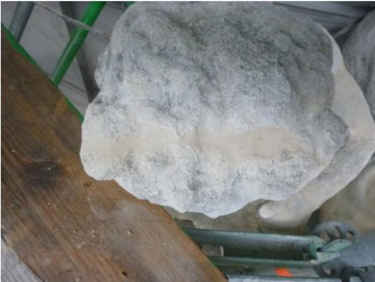
Nach dem Injizieren wurden die Risse bündig zur Oberfläche mit Steinersatzmasse verschlossen.
