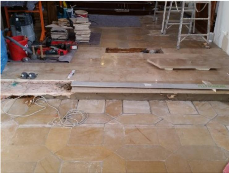
Für die neue Chorstufe wurde der Plattenbelag an dieser Stelle entfernt und die vorhandenen Stufen entsprechend der angepassten Maße neu versetzt.
