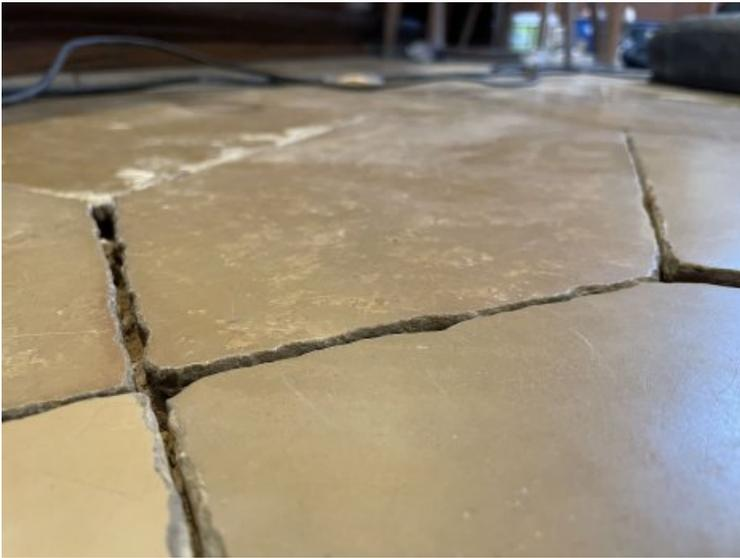
Arbeitsfoto: Vor dem Einbringen des Fugenmörtels wurden die geöffneten Fugen von Staub und anderem Lockermaterial gereinigt.
