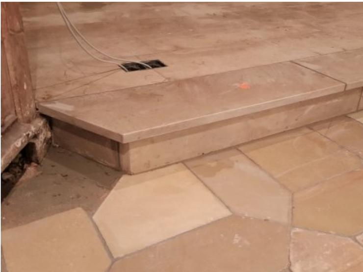
Neu versetzte Chorstufe mit ergänztem Bodenbelag, die Fehlstelle im linken Bildteil wird später von einem hölzernen Trittpodest überdeckt.
