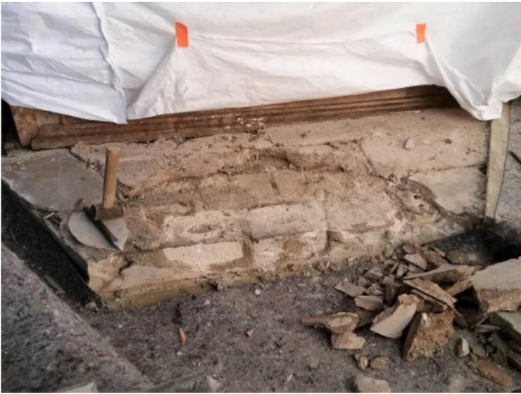
Linkes Podest nach Abnahme der Kalksteinplatten.
