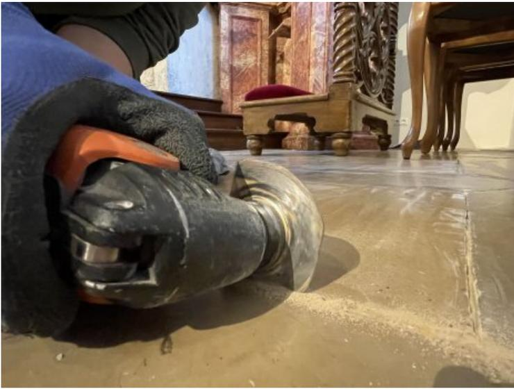
Defekte, gerissene oder stark zurückgewitterte Fugen wurden bis zu einer Tiefe von 15 mm mit einem oszillierenden Schneidwerkzeug geöffnet.
