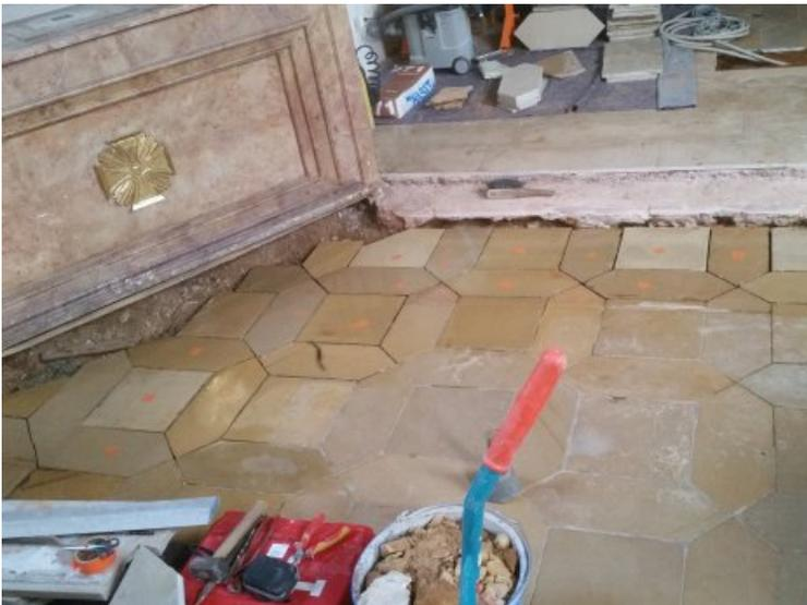
Die entstandenen Fehlstellen wurden mit Solhofer Platten entsprechend des Bestandes geschlossen. Die Stufe zum Chorraum wurde um eine Trittbreite reduziert, sodass sie wieder mit den Vorkanten der Podeste der Seitenaltäre abschließt.
