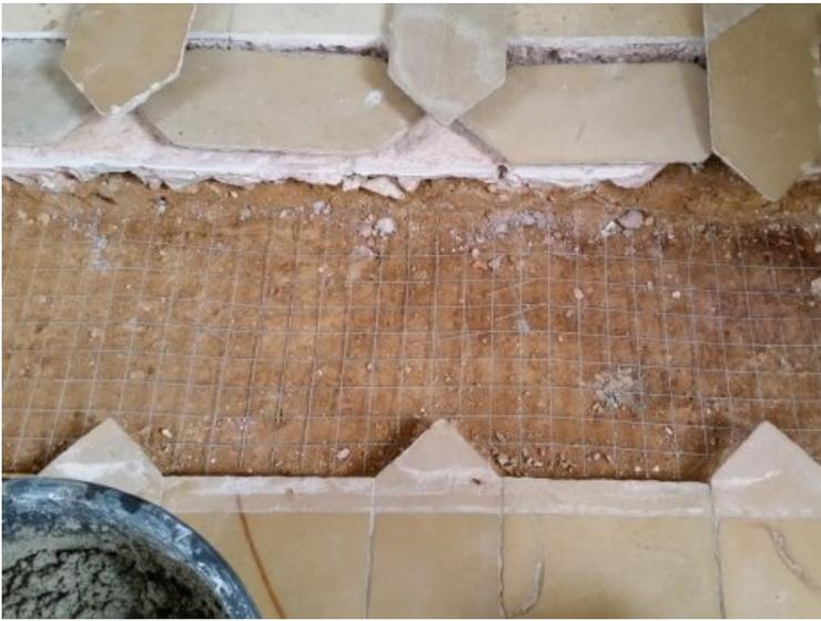
Aufgrund der Reduzierung der Trittbreite mussten zusätzliche Bodenplatten verlegt werden. Hierfür wurde ein drahtarmerter Estrich als Untergrund eingebracht.
