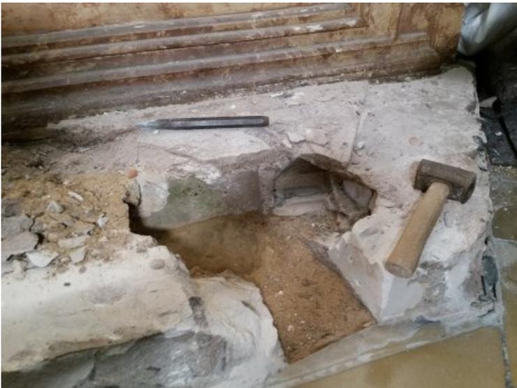
Während des Abbaus des Unterbaus aus Kalkzementsteinen.
