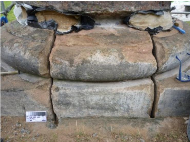
Die geöffnete Standfuge der Säule mit temporären Mörtelkeilen unterhalb der Heunensäule
