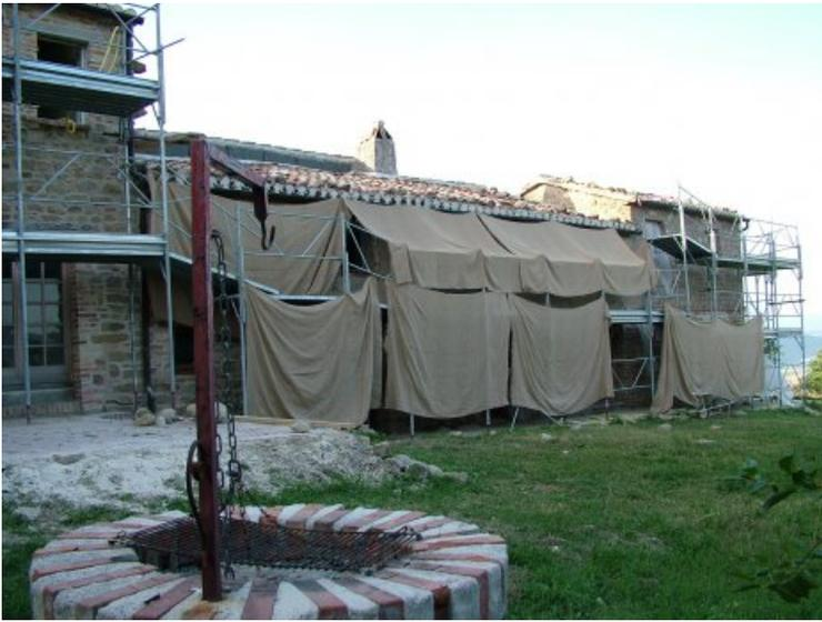
Zum Schutz vor zu schneller Trocknung der Mörtel wurde das Mauerwerk mit Jutegewebe abgehängt.
