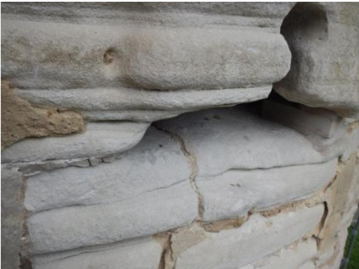
Verwaschene Formen und eine desolante Verfassung zeichneten das Bild der Turmfassade
