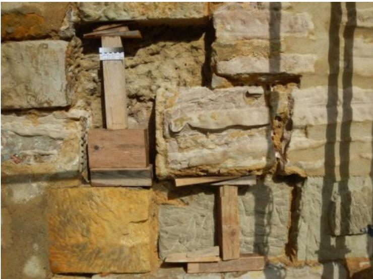
Beim Ausbau nicht mehr konsolidierbarer Steine wurde das Mauerwerk zusätzlich abgestützt
