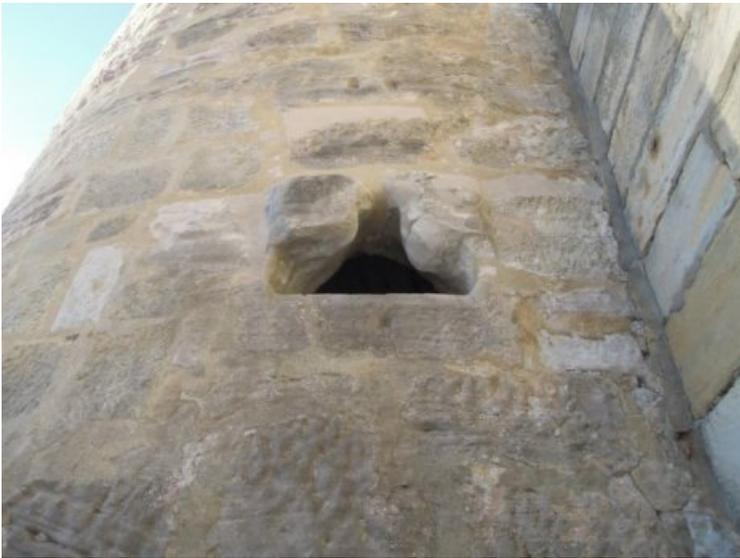
Der bearbeitete Teilabschnitt ist visuell wieder an das umgebende Mauerwerk angeglichen
