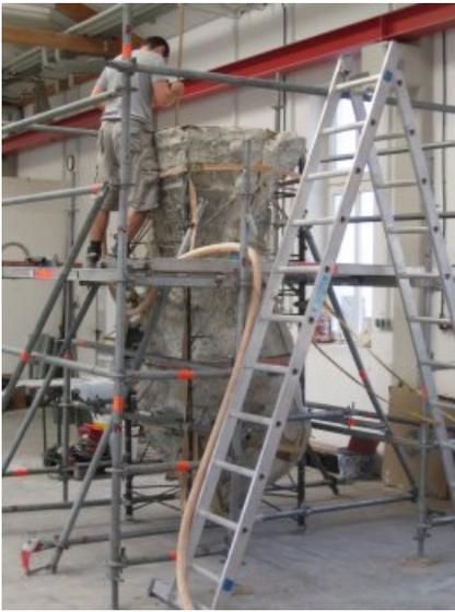
Kontrolliertes Füllen der Abgussform mit Transportbeton.
