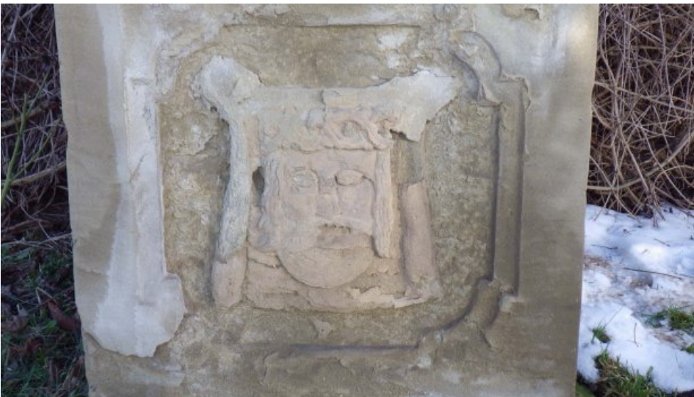
Detail des sehr desolaten Sockels mit Schweißstuch-Relief, vor der Maßnahme.
