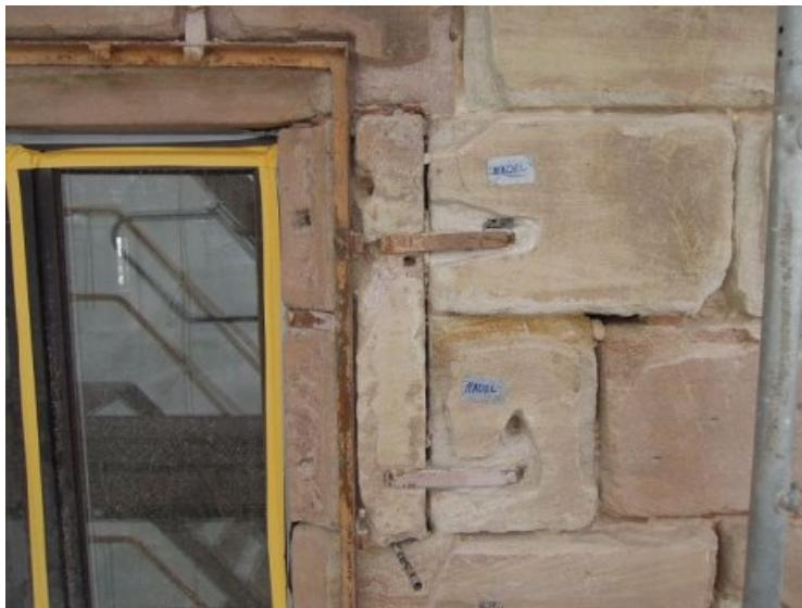
Neben der Ausarbeitung von Fehlstellen und Fugen mussten an einigen Steinquadern zudem V4A-Edelstahlnadeln gesetzt werden.
