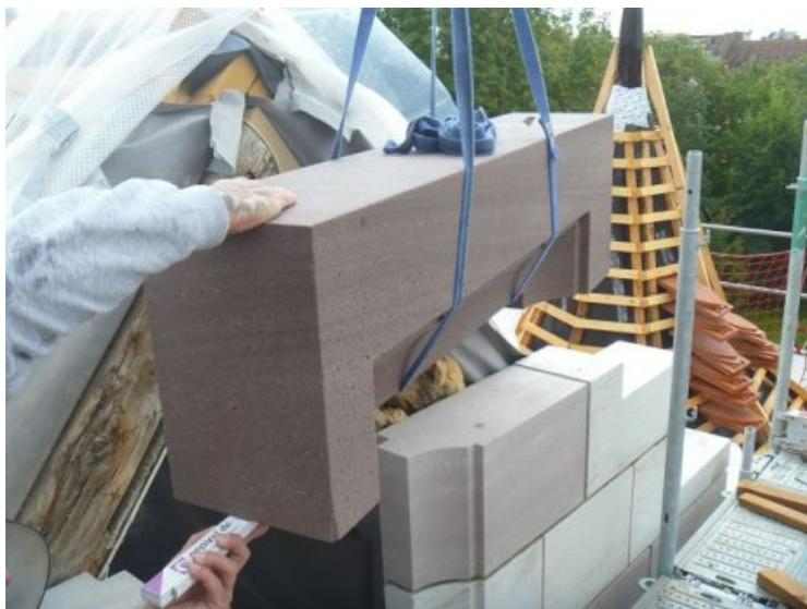
Sowohl West- als auch Ostgiebel des Herrensitzes mussten in Teilen ab- und wiederaufgebaut werden, einige Steine wurden zudem durch angepasste Neuteile ersetzt.
