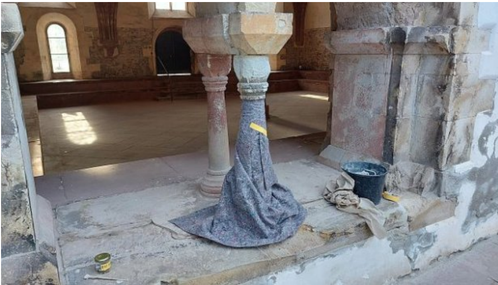
Das stark entfestigte Kapitell der vorderen Säule des linken Zwillingsfensters wurde mit Kieselsäureester gefestigt. Während der Behandlung wurden angrenzende Bereiche gesichert.
