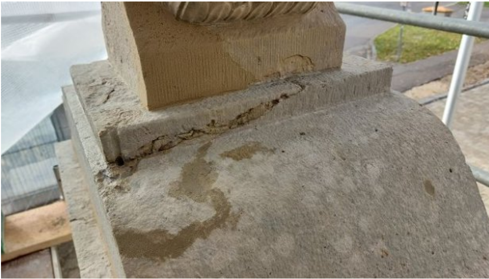
Ergänzung der Fehlstelle und Verschlämmen des oberflächlichen Risses.
