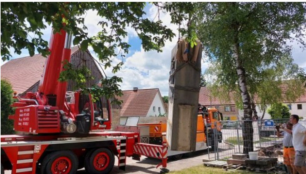
Verladen der Einzelteile mit Hilfe eines Autokrans und anschließender Transport zum Bauhof.
