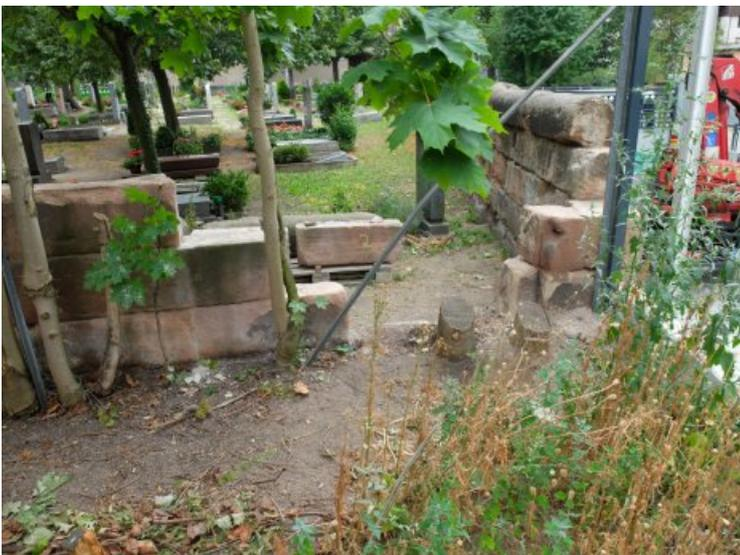
Zur Sicherung der Mauer wurden deformierte Teilbereiche abgebaut.
