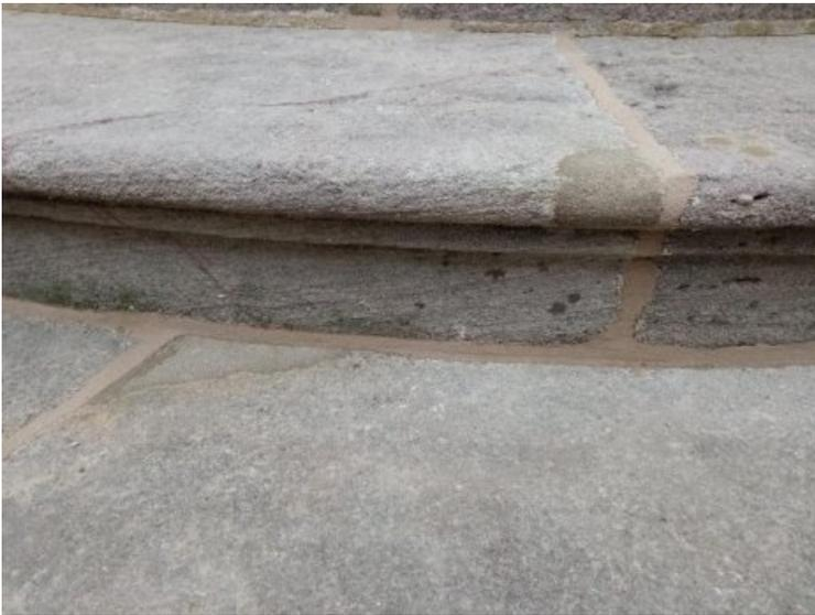
Ausbrüche treten vor allen an auskragenden Bauteilen auf.
