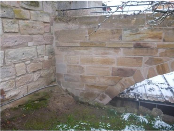
In großflächige Fehlstellen wurden Neuteile oder Vierungen eingesetzt, kleinere Schäden wurden mit Ergänzungsmörtel angepasst. Die Fugen wurden komplett ausgetauscht.
