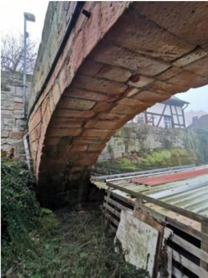
Die Unterseite der Brücke zeigt Risse, defekte Fugen und Algenbewuchs.
