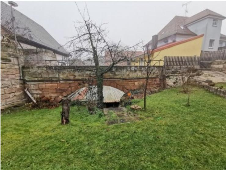
Die Brücke im Vorzustand: Es treten biogener Bewuchs, defekte Fugen, Risse im Mauerwerk und stark reduzierte Werksteine auf.
