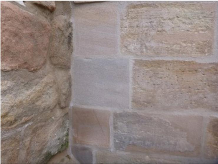
Im Anschlussbereich zur Mauer mussten nicht mehr konsolidierbare Quader mit Neuteilen ausgetauscht werden.
