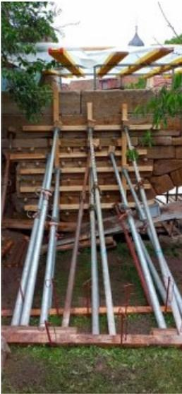
Das instabile Mauerwerk wurde durch eine Konstruktion aus Kanthölzern und Sprießen gesichert.
