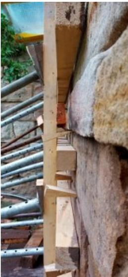
Durch etappenweises Drehen der Sprieße wurde die Mauerflucht wiederhergestellt. Die Quader wurden durch Keile in den Fugen gesichert.
