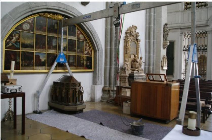
Abbau der Tumba mit Hilfe des Portalkrans.
