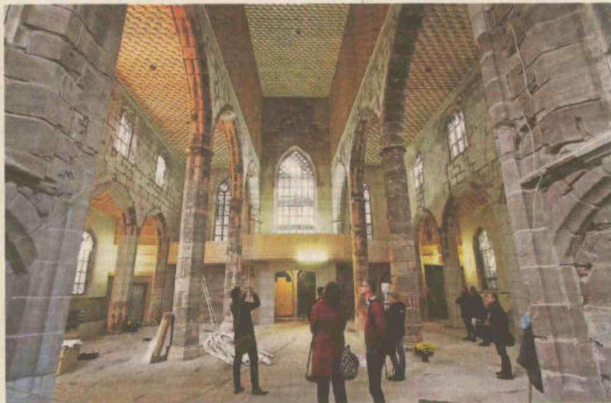
Ein Blick vom Chor in das nun breiter und höher wirkende Kirchenschiff von St. Martha: Die neue Holzdecke erfüllt nicht nur optische und akustische Funktionen, sondern gehört auch zum Tragwerk der Dachkonstruktion. Foto: Eduard Weigert
