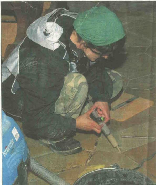
Auch das dient dem schonenden Erhalt des Fußbodens aus Kelheimer Platten: Mit einer Spritze füllen die Fachleute Pflasterfugen mit Mörtel sorgfältig auf.
